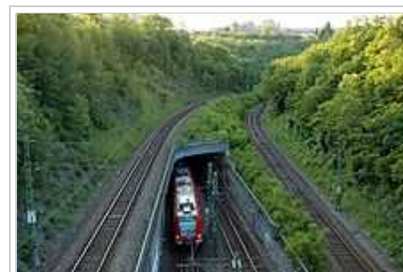
Die oberirdische Gäubahn und der 1985 fertiggestellte, 8,8 Kilometer lange Tunnel der Verbindungsbahn Stuttgart in Stuttgart-Vaihingen
